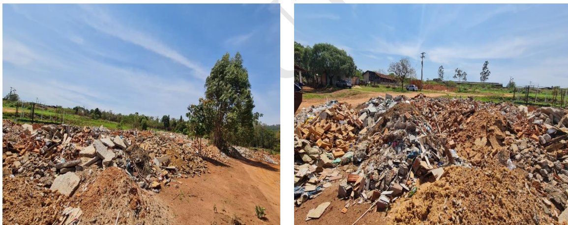
Figura 46 e 47 – Disposição de RCC na ATT. Fonte: Amplar Engenharia
