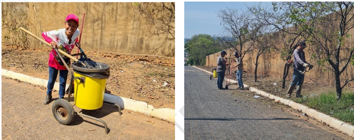
Figura 40 e 41 – Equipe de limpeza corretiva Fonte: Amplar Engenharia
