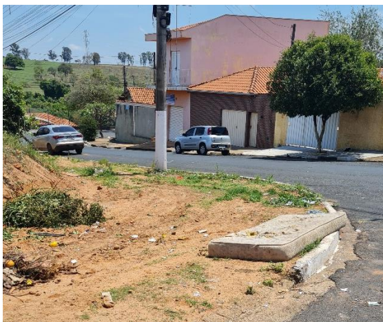
Figura 30 – Ponto com descarte incorreto Fonte: Amplar Engenharia
