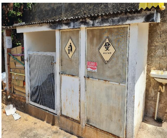
Figura 44 – Local de armazenamento de RSS Fonte: Amplar Engenharia
